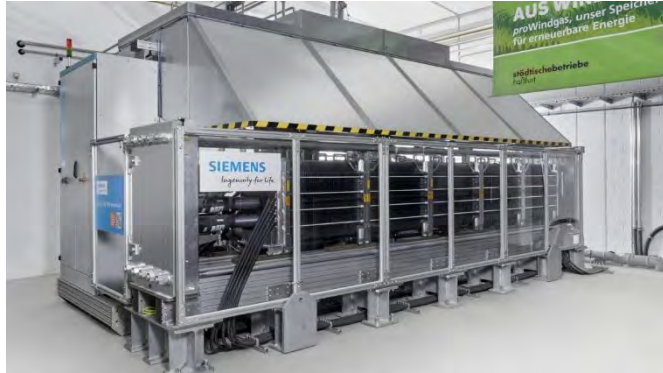
Siemens PEM Electrolyzer (Source: Siemens)
